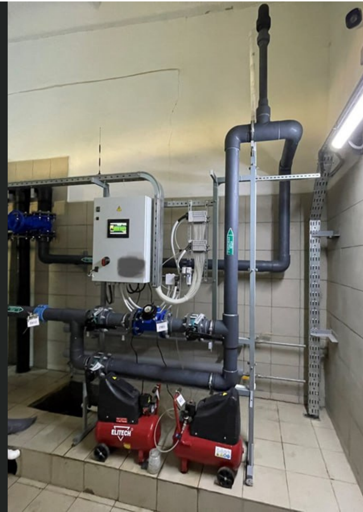
Станция обезжелезивания 1200м3 в сутки
